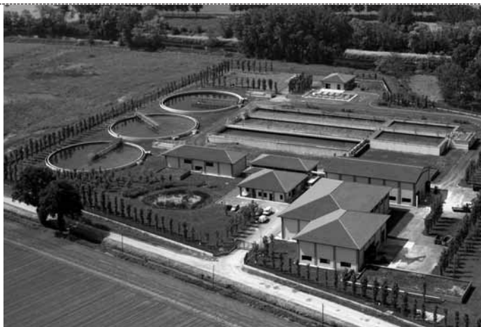
L'impianto di depurazione delle acque di Locate Triulzi (Mi)
